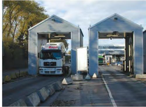
In diesen Scan-Portalen werden LKW und Trailer mit digitalen Kameras von allen Seiten erfasst.
