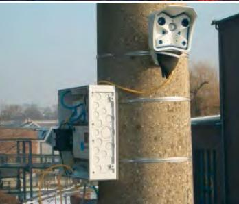
MOBOTIX Kamera mit der (während der Installation noch offenen) Mobile Connect Box für die UMTS-Übertragung.
